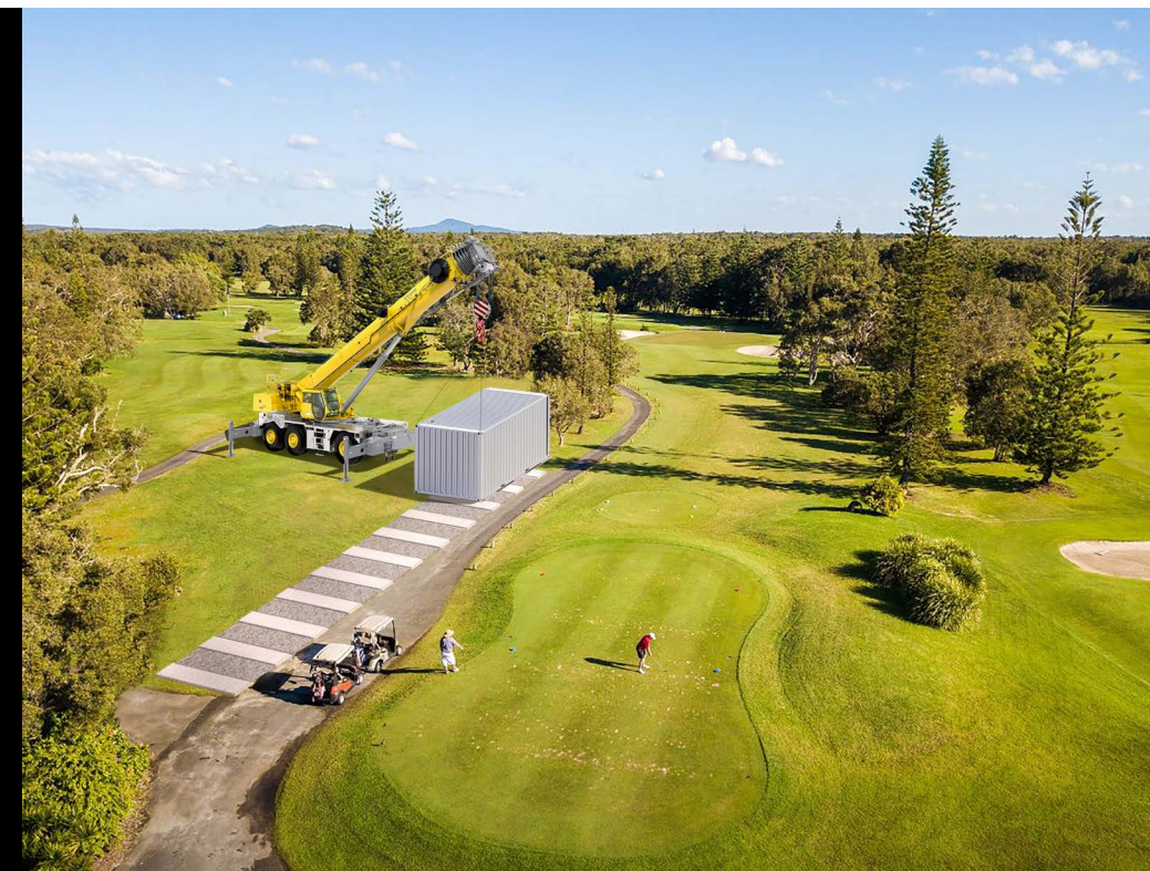
... DOPRAVA NA STAVENIŠTĚ
